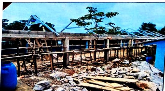
Foto 6: colocacion de costaneras
