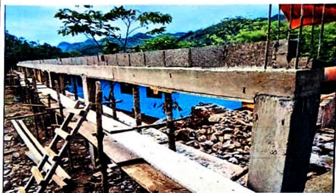
Foto 3: colocacion de columnas y tabique en salon
