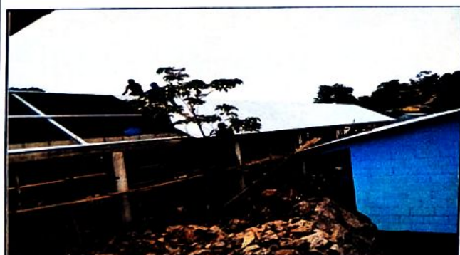
Foto 5: cambio y colocacion de entechado
