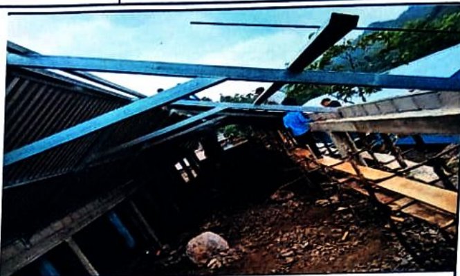
Foto 2: colocacion y cambio de techo en salon
