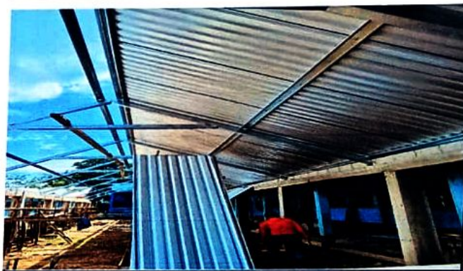
Foto 4: cambio de techo
