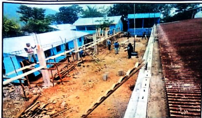
Foto1: colocacion de horcones de concreto
